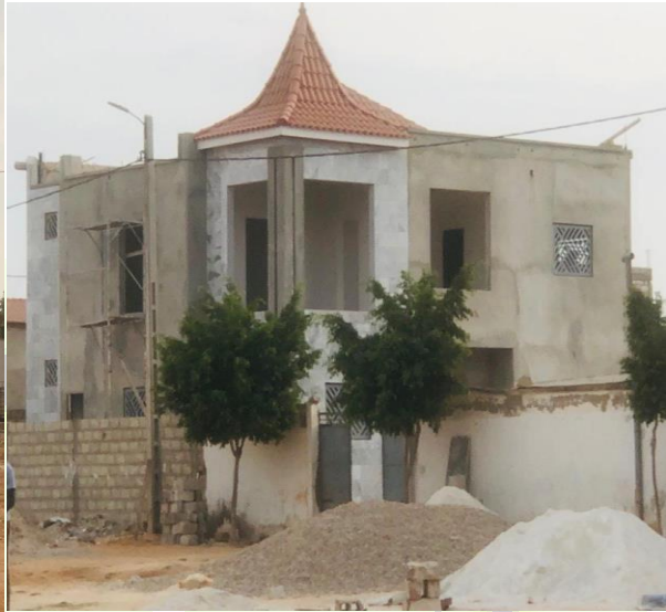
La première maison d'hôtes réfectionnée
