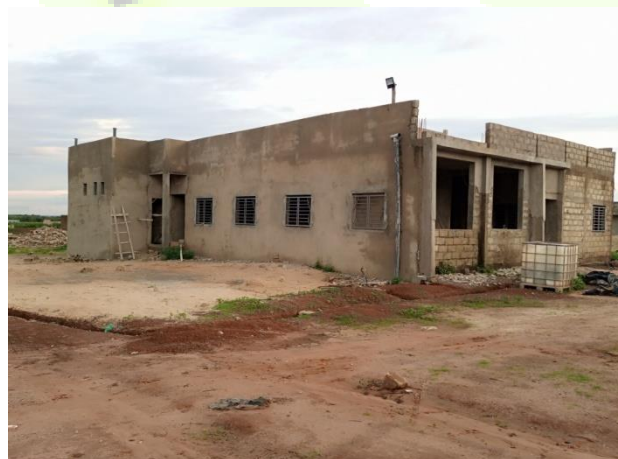
Le Poste de Santé en phase de finition
