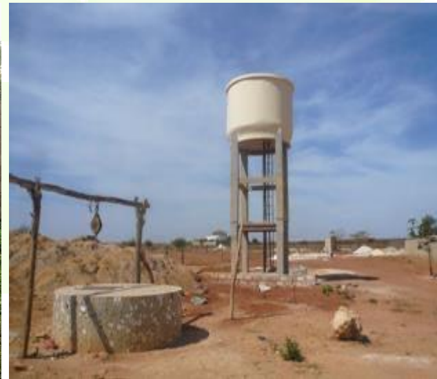
Le château d'eau et le deuxième puits de Darou Salam
